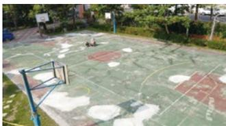
量測高程，將球場凹陷、縫隙處補平
